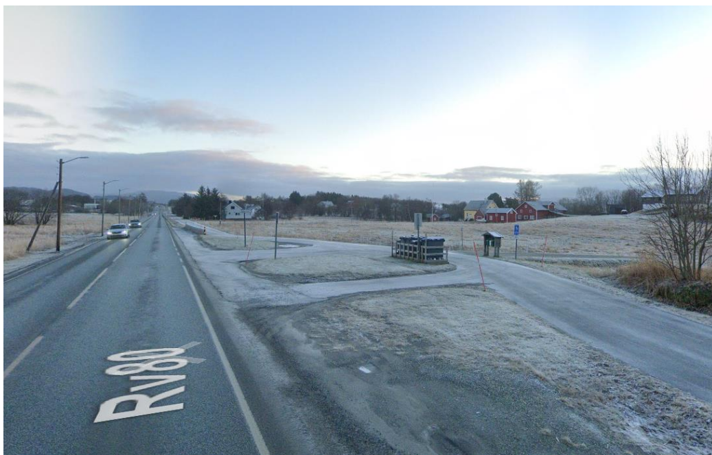
Figur 16. Krysset vest i planområdet ved Buveien sett imot øst. Kilde: Google street view.
